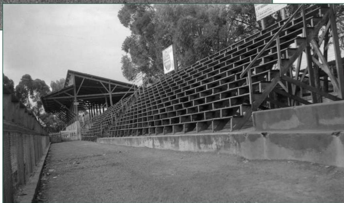
Imagens das “Sociais” (ampliadas nos anos 40, com oito vigas de sustentação e degraus adicionais) e das arquibancadas, à sua direita e esquerda, também com degraus extras próximos ao solo (fotos V8).
